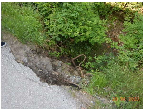
Слика 2а,б,ц,д - локације на којима се види стање прихватних канала и цеви за површинске воде и оштећења пута услед ерозије обале кроз село Субал
