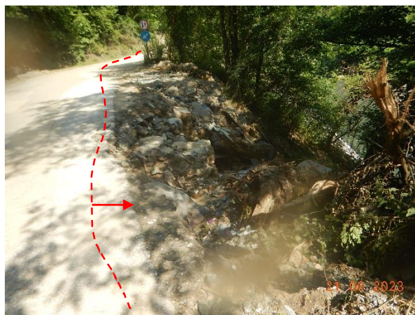
Слика 11а,б,ц,д – оштећења пута на више места на потезу од 150м
