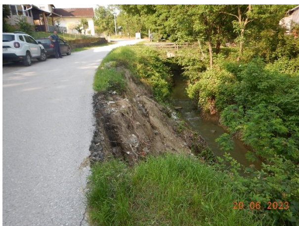
Слика 2а,б,ц,д - локације на којима се види стање прихватних канала и цеви за површинске воде и оштећења пута услед ерозије обале кроз село Субал
