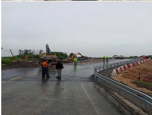
Фото – Хитна интервенција на изградњи привремене девијације на Ибарској магистралаи, прелаз преко Мусине реке у насељеном месту Адрани, јун 2023. год. (фото – Цивилна заштита града Краљева)
