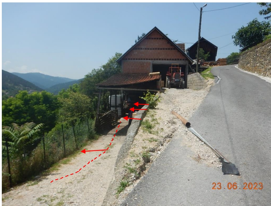
Слика 17- улаз ка шталу на чијем путу се види ожилјак клизишта, обложни зид који се полако нагнуо напред и цев која је постављена да прикупи воде и изведе их ван зоне клижења
