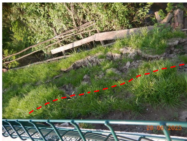
Слика За,б,ц,д - локација на којој је дошло до ерозије обале, чиме је угрожен плац Драгољуба Радовића
