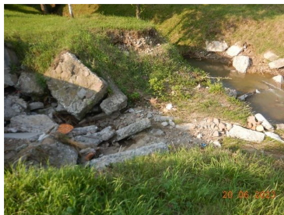
Слика 4а,б - разорен испуст за прихват вода на Стубалској реци
