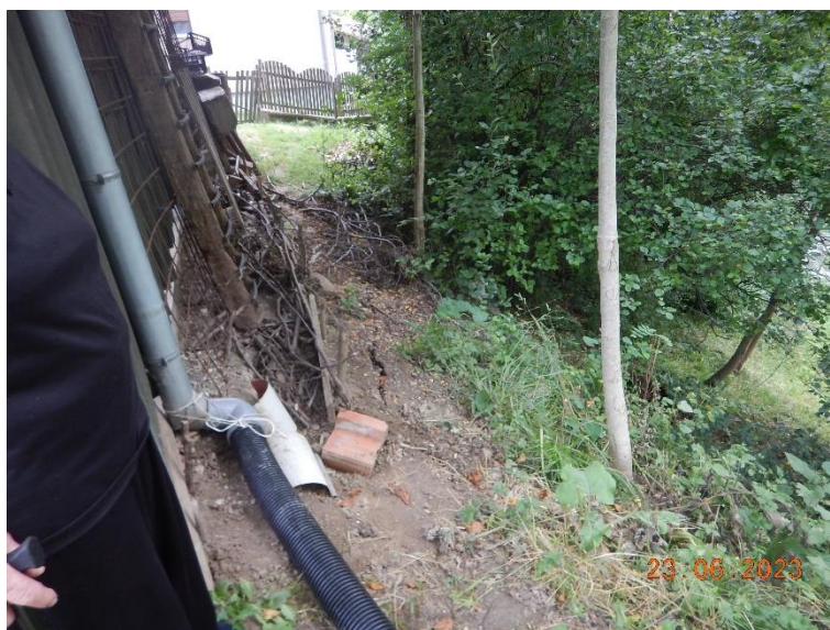
Слика 20 - Ожиљак клизишта на терасном одсеку, непосредно уз помоћни објекат
