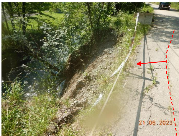
Слика 10а,б - земљаста распадина ДРФ формације, и формиран извор на тачки 12
