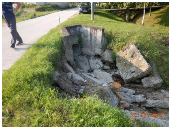
Слика 4а,б - разорен испуст за прихват вода на Стубалској реци
