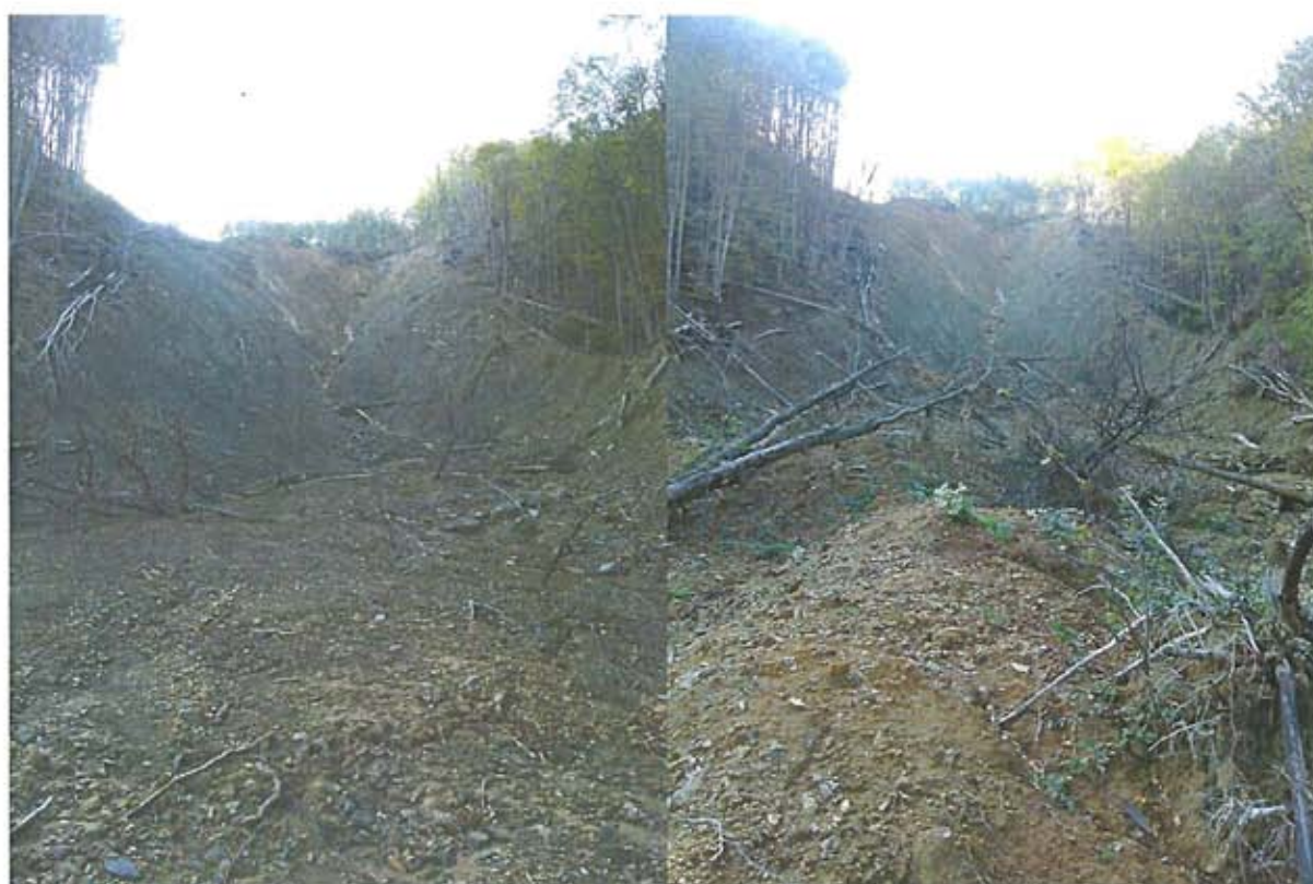
Слика 6. Изглед „левкасте“ јаруге дуж које је материјал покренут, а кроз коју вода и даље отиче (фото К.Андрејева)
