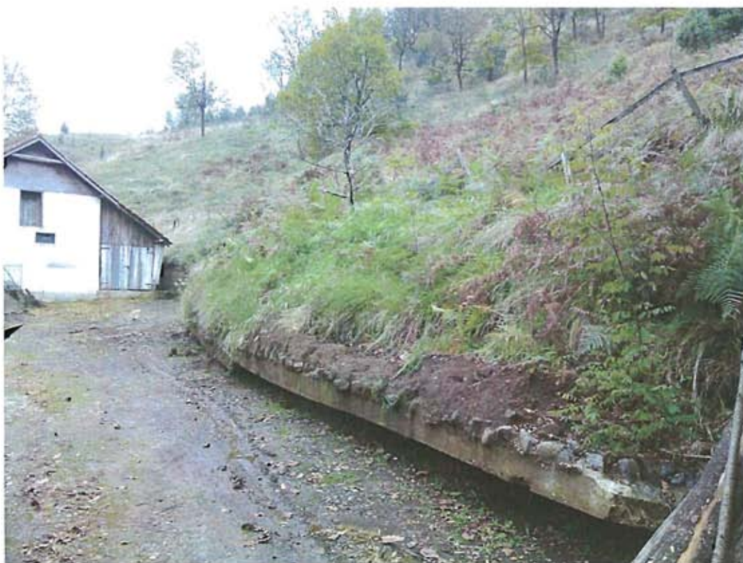
Слика 5. Претурен потпорни зид под притиском земљаасте масе (фото К.Андрејев)
