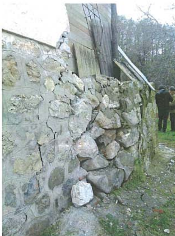
Слика 8. Детаљ ивичног дела куће где је дошло од деформације услед клижења (фото К.Андрејев)
