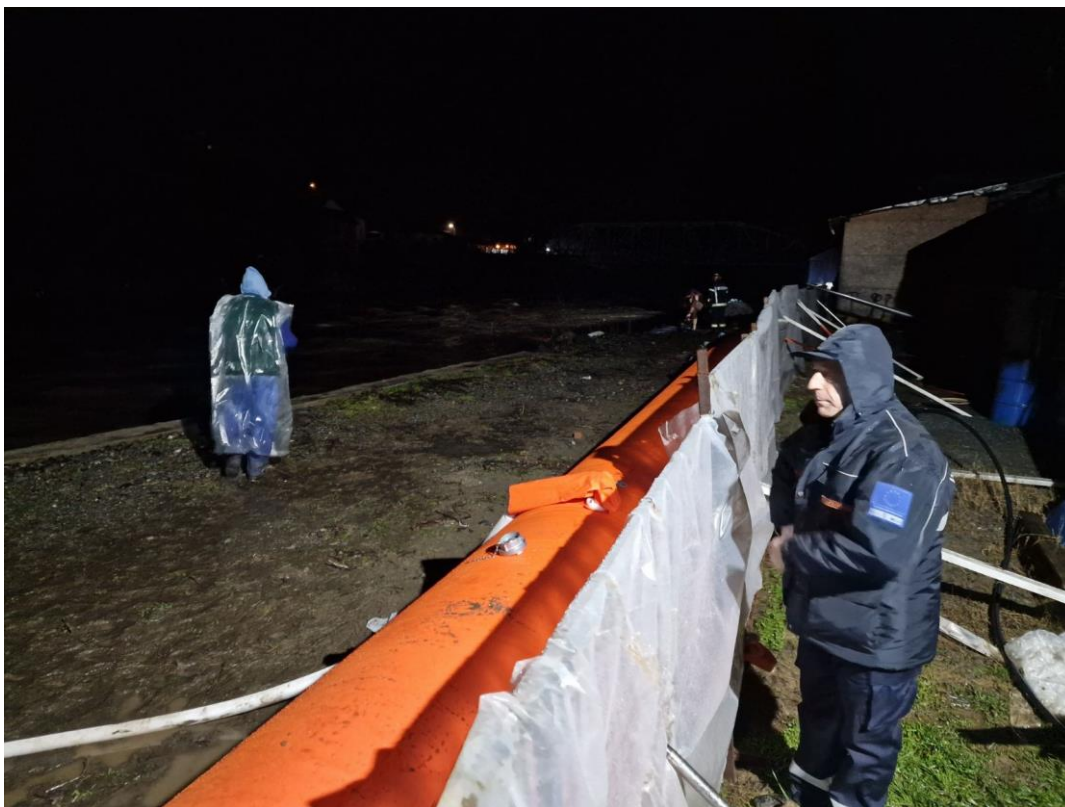
Слика бр. 5. - Ангажовање припадника Цивилне заштите на постављању мобилних противпоплавних система
