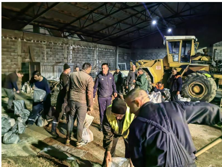
Слика бр. 3. - Ангажовање запослених ЈКП „Чистоћа“ и ЈКП „Водовод“ на пуњењу цакова песком за изградњу насипа
