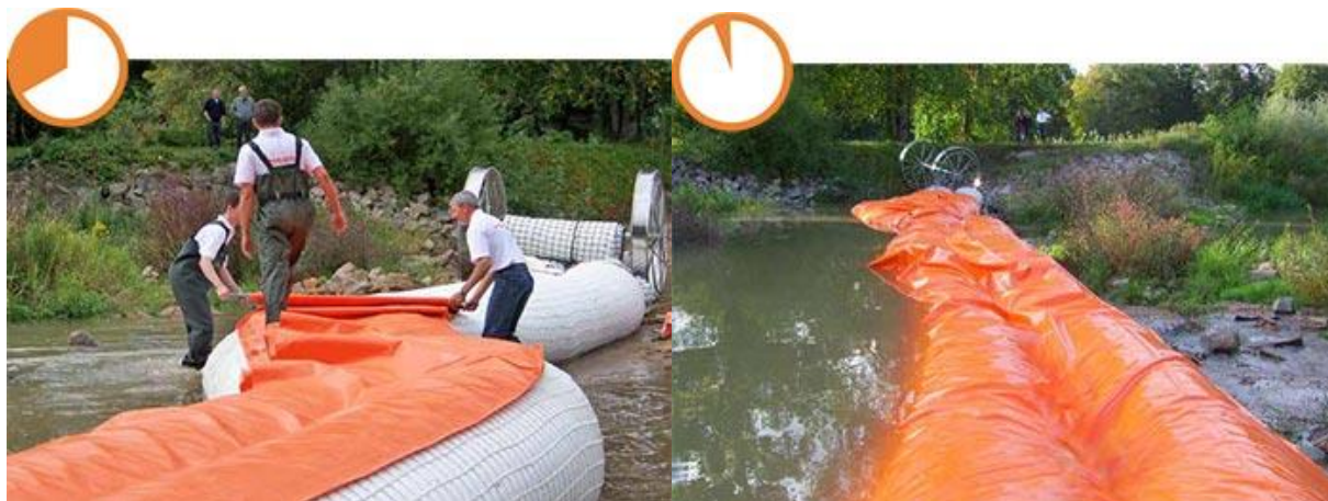
Slika 30 Postavljanje membrane
