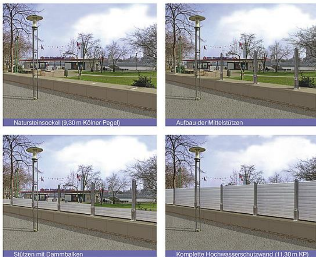
Slika 26 Instalacija mobilnog odbrambenog zida
