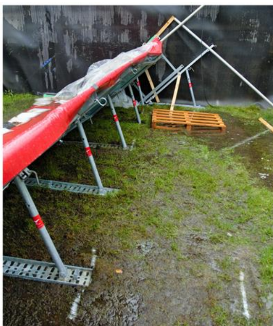
Slika 25 Konstrukcija postavljena na mekanoj podlozi
