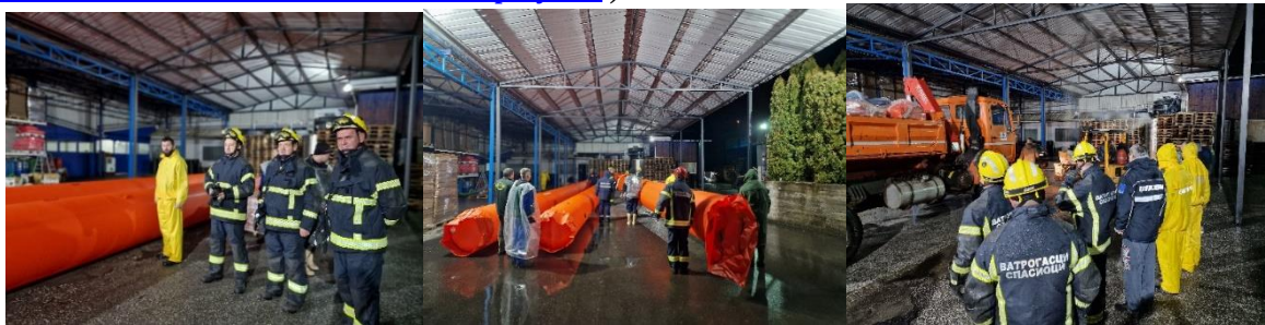
Фотографије 1-3 – инсталација мобилних противоплавних система на локацији Екофарм Ушће код Краљева, јануар 2023. год. (извор: Цивилна заштита Краљево)
